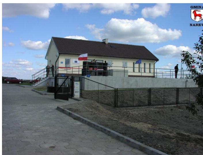
Rys. 11 Oczyszczalnia ścieków w Narwi
